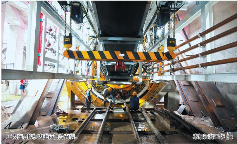
工人在盾构机内进行管片安装。
